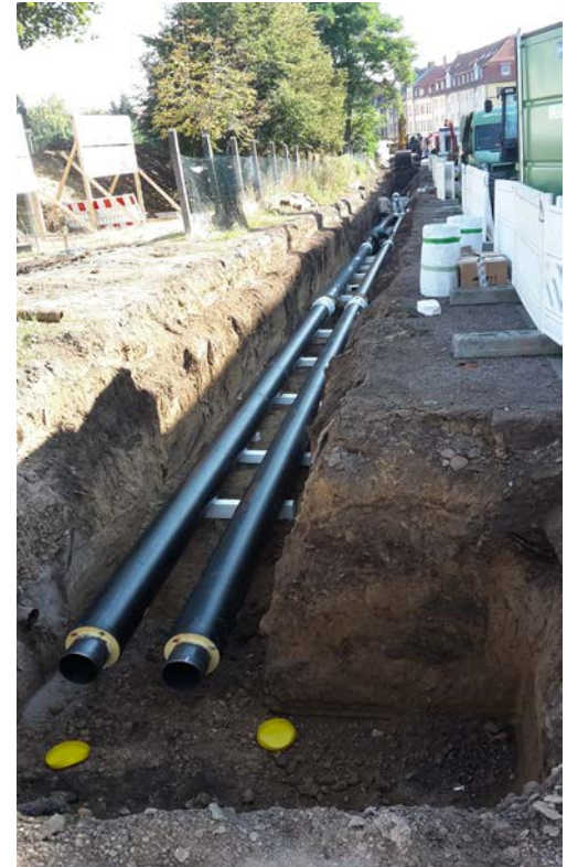
© Fernwärmeleitungen im Borntalweg (SWE)
