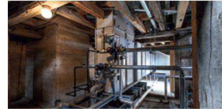
Das Projekt kombiniert den Einsatz eines BHKW mit einer Absorptionskälteanlage. Im Sommerbetrieb erfolgt somit die Nutzung der Abwärme über das Rückkühlwerk der Kältemaschine zur Kühlung, im Winterbetrieb wird diese zur Gebäudeheizung eingesetzt. Die Maßnahme zeichnet sich durch intelligente Einbindung des BHKW und die Nutzung des thermischen Potenzials für Heizung und Kühlung aus.
