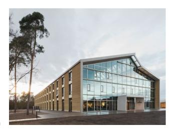
Die Stampflehmfassade, die aus recyceltem Material gefertigt wurde, besteht aus einer 17 cm starken Kerndämmung aus Schaumglasschotter und dem Tunnelaushub des Bahnprojekts Stuttgart 21. Sie funktioniert als langlebige und nachhaltige Fassadenkonstruktion, die nahezu keine graue Energie beinhaltet. Der Lehm reguliert die Luftfeuchtigkeit des Innenraumklimas und benötigt keinen weiteren Pflegeaufwand. Horizontale Regenwasserbremsen schützen die Fassade vor Verwitterung.
