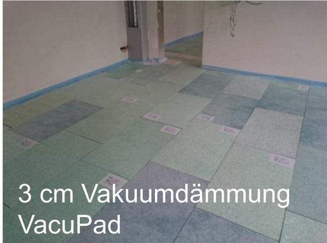
3 cm Vakuumdämmung
