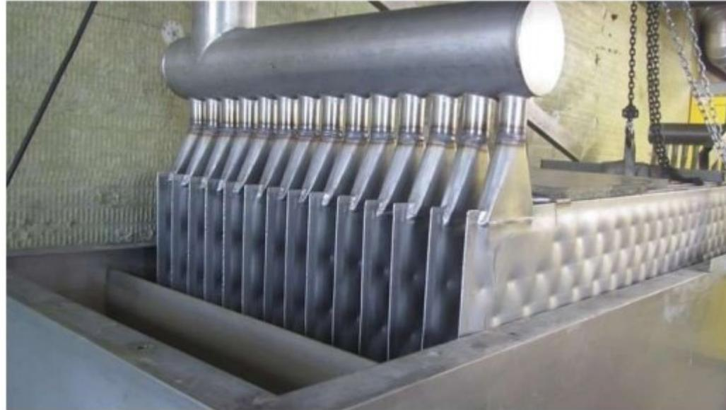
Abbildung 3: Plattenwärmetauscher (Quelle: Fa. Anthermo 2021)
