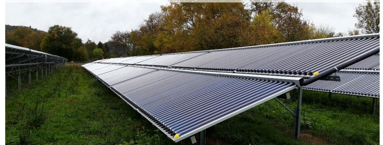
Vakuum-Röhrenkollektor: 400 – 540 kWh/(m<sup>2</sup><sub>Brutto</sub>·a)
